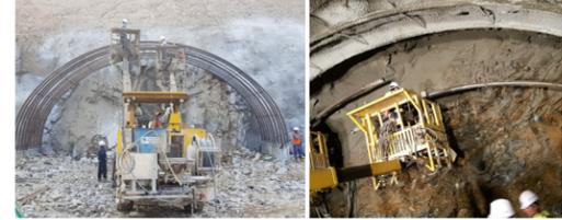
(주)티에스테크 마상준 연구소장, 전윤재 부장이 개발한 본 제품은 터널시공 시 굴착면에 설치하여 굴착지반 안정화를 위해 사용하는 강지보재이다. 세계 최초 CFT공법을 적용하였으며, 공극이 발생하지 않아 지하수로 인한 내구성 저하를 방지한다. 연결부 개선으로 시공시간 단축 및 국가 설계기준에 만족하며, 용접 부위 최소화로 균일한 품질을 얻을 수 있다. 기존 격자지보가 가지는 문제점들을 해결한 뛰어난 성능의 지보재이다.
