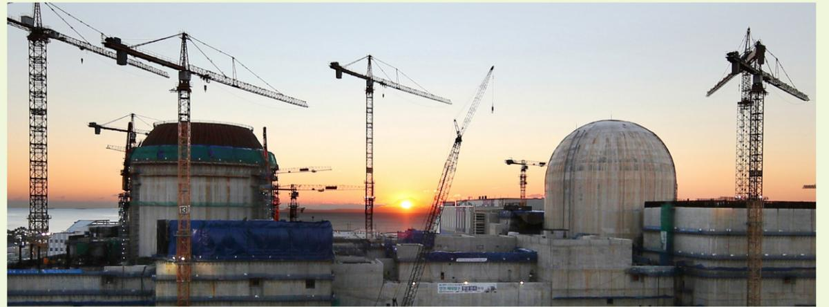
사진 1 신고리원자력발전소 5·6호기(1400MW×2기)는 전 세계에서 원자력기술이 가장 진보한 모델이다. APR1400(Advanced Power Reactor) 노형의 국내의 선형원전 경험과 일본 후쿠시마 원전사고 이후 규제기관의 인허가 요구사항 등 대폭적인 안전성관련 개선사항이 실제에 반영됐다.
