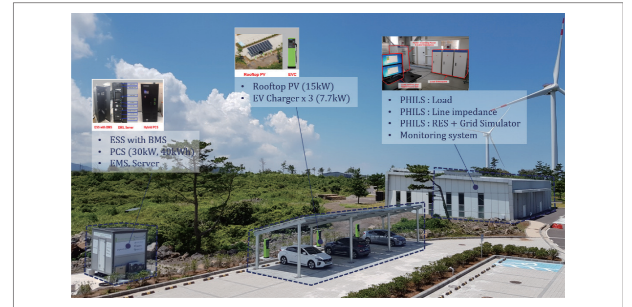
그림 1. 하이브리드형 분산전원 전기자동차 충전시스템 실증 플랫폼
