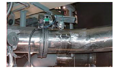
<배관 용접부 자동초음파(AUT) 검사>
