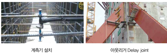
그림 2 계측기 설치 및 아웃리거 보정
