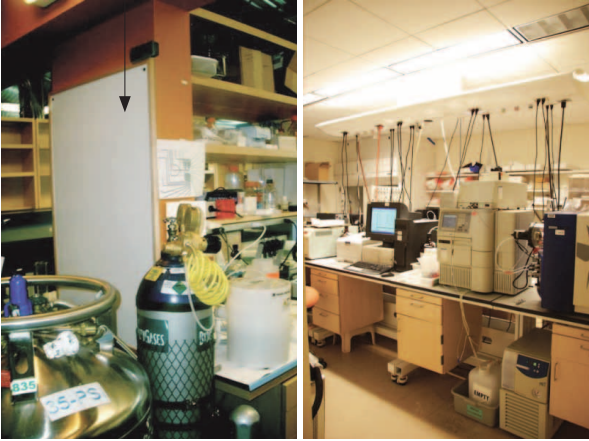
천장의 샤프트를 경유하여 연구벤치에 공급 천장에서 랙을 경유하여 각 기기에 직접공급
