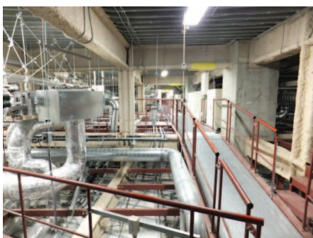
그림 13 콘크리트 슬라브가 아닌 간이 ISS
