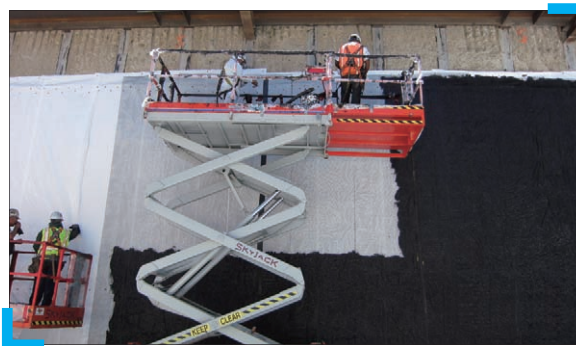
샌프란시스코 BART 시공현장
