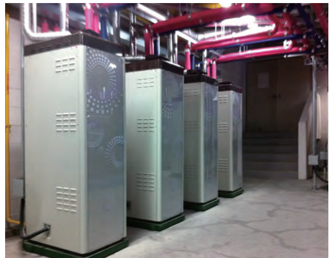
그림 2) 퓨어셀파워의 가정용 연료전지 시스템 설치 모습
