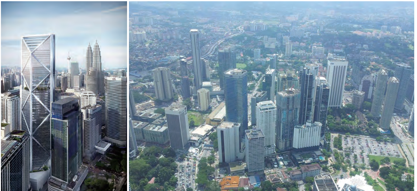
그림 4) 초고층 빌딩 기술을 지원하는 말레이시아 IB타워 현장
