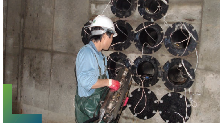
전력신기술 제14호 관련, 노변 송전 선로 지중화 공사 관로 도통시험 현장.
